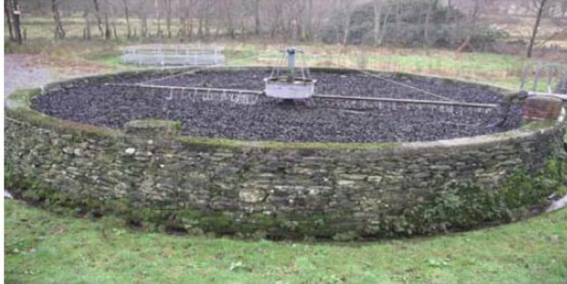
Rysunek 2. Przykład złoża biologicznego z wypełnieniem stałym (złożo zraszane)
