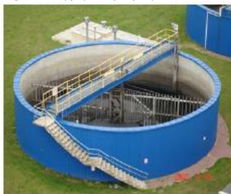
Rysunek 8. Zagęszczacz grawitacyjny pracujący w sposób ciągły (Wrocławska Oczyszczalnia Ścieków)
