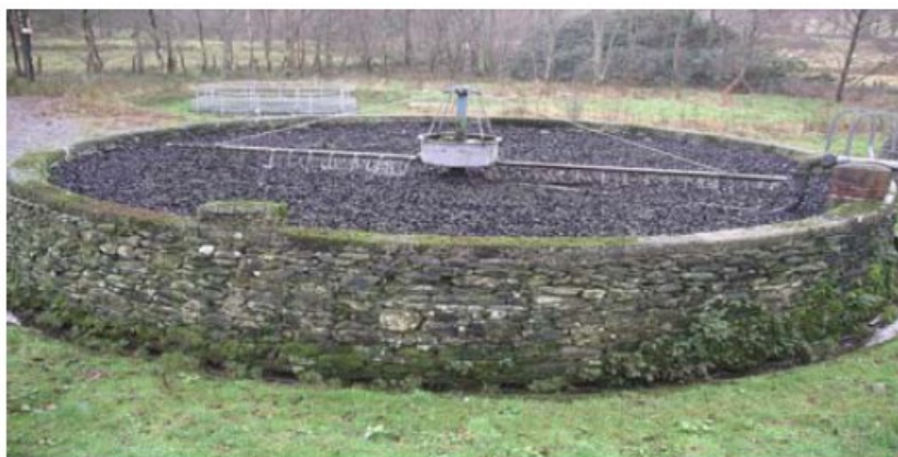
Rysunek 2. Przykład złoża biologicznego z wypełnieniem stałym (złożo zraszane)
