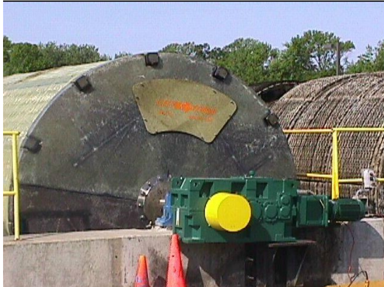
Rysunek 3. Przykład złoża biologicznego z wypełnieniem ruchomym (złożo tarczowe)
