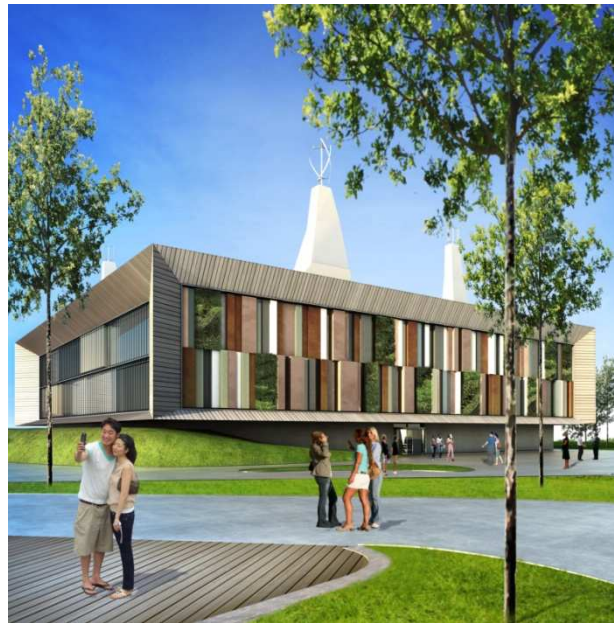
Rysunek 2 Widok tylnej elewacji budynku (Kucia, 2010).
