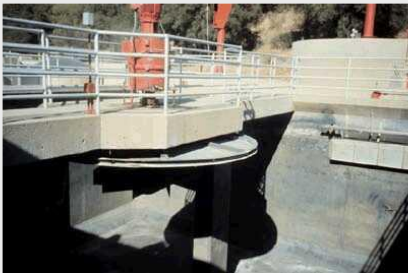
Napowietrzanie aeratorem mechanicznym o wale pionowym
