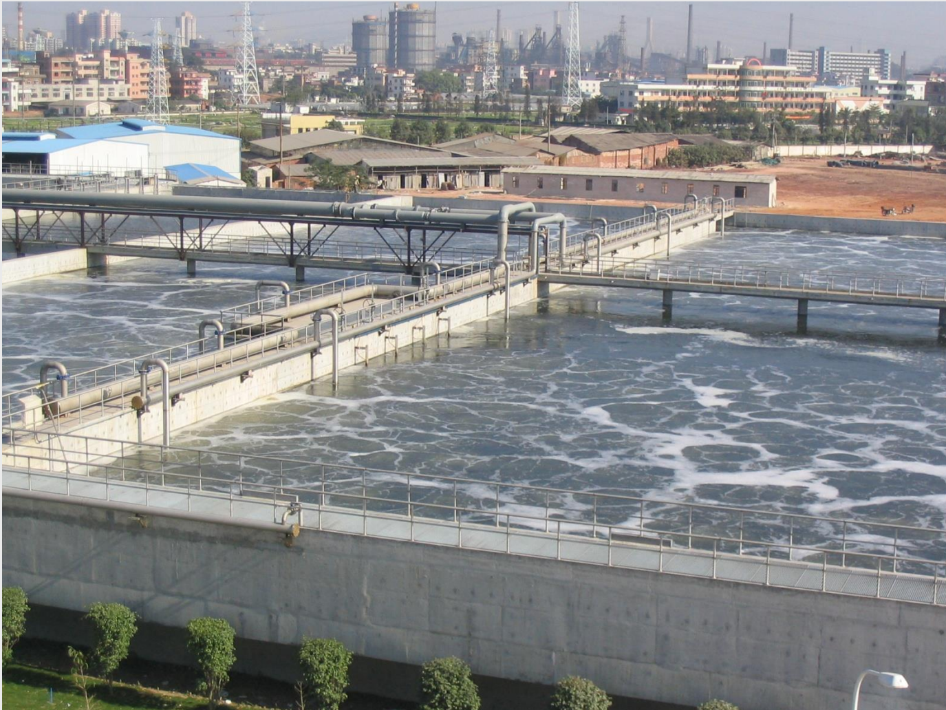
Napowietrzanie sprężonym powietrzem
