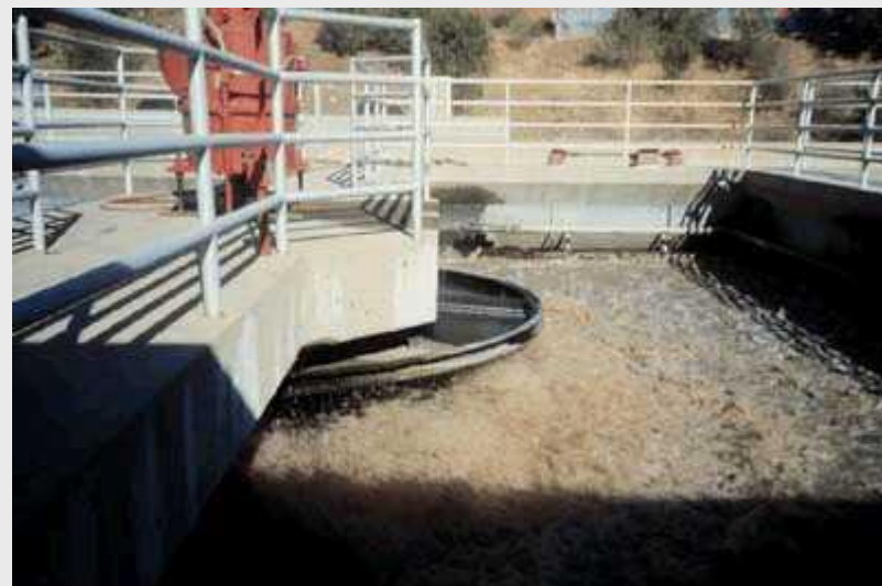
Napowietrzanie aeratorem mechanicznym o wale pionowym
